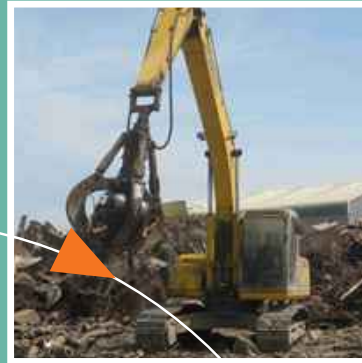
Centro de acopio
