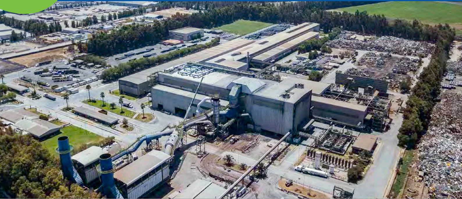
Vista aérea de la planta Colina de Aceros AZA.
