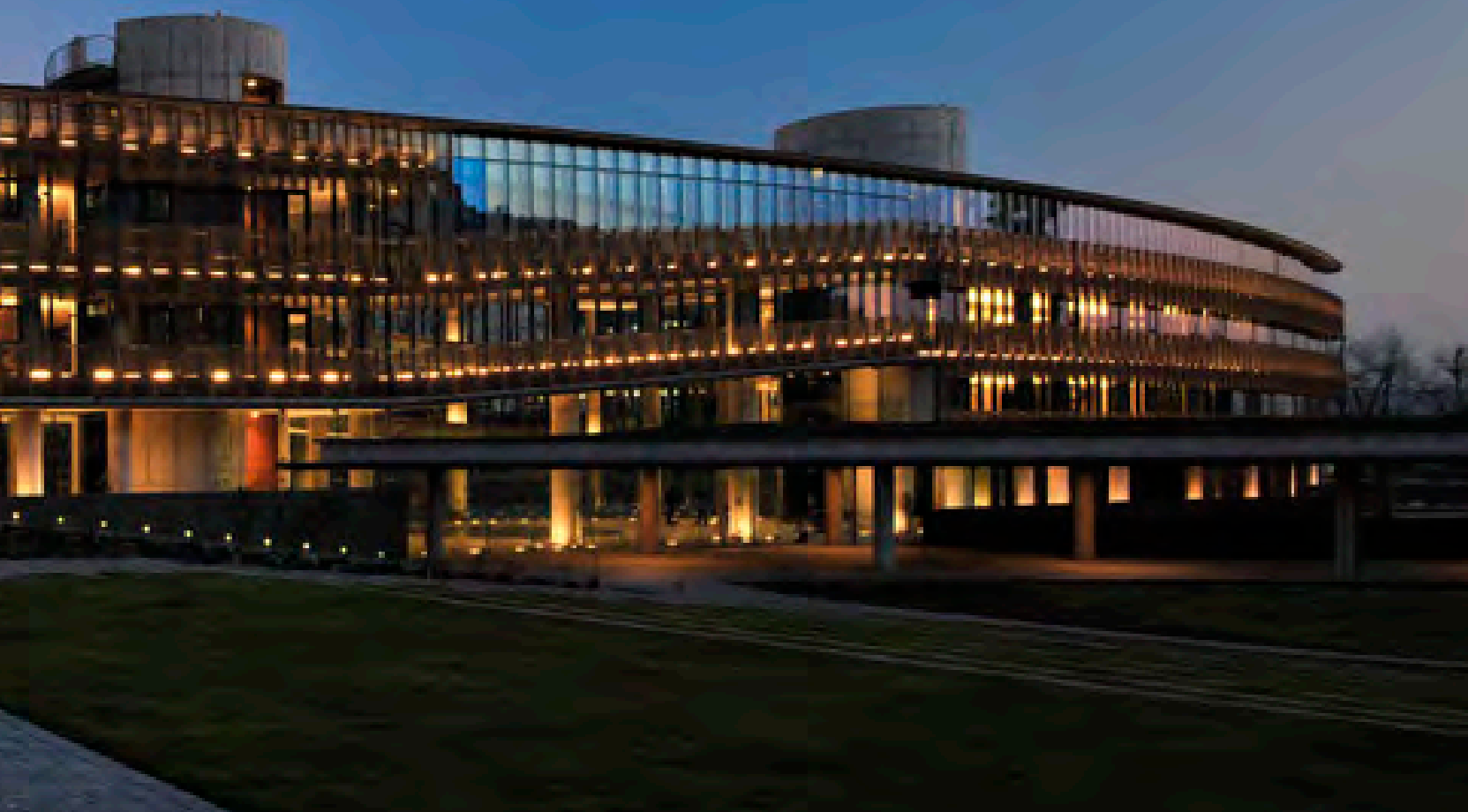
Edificio Transoceánica Proyecto de arquitectura: +arquitectos Certificación LEED® Categoría Gold Construido con acero reciclado AZA
